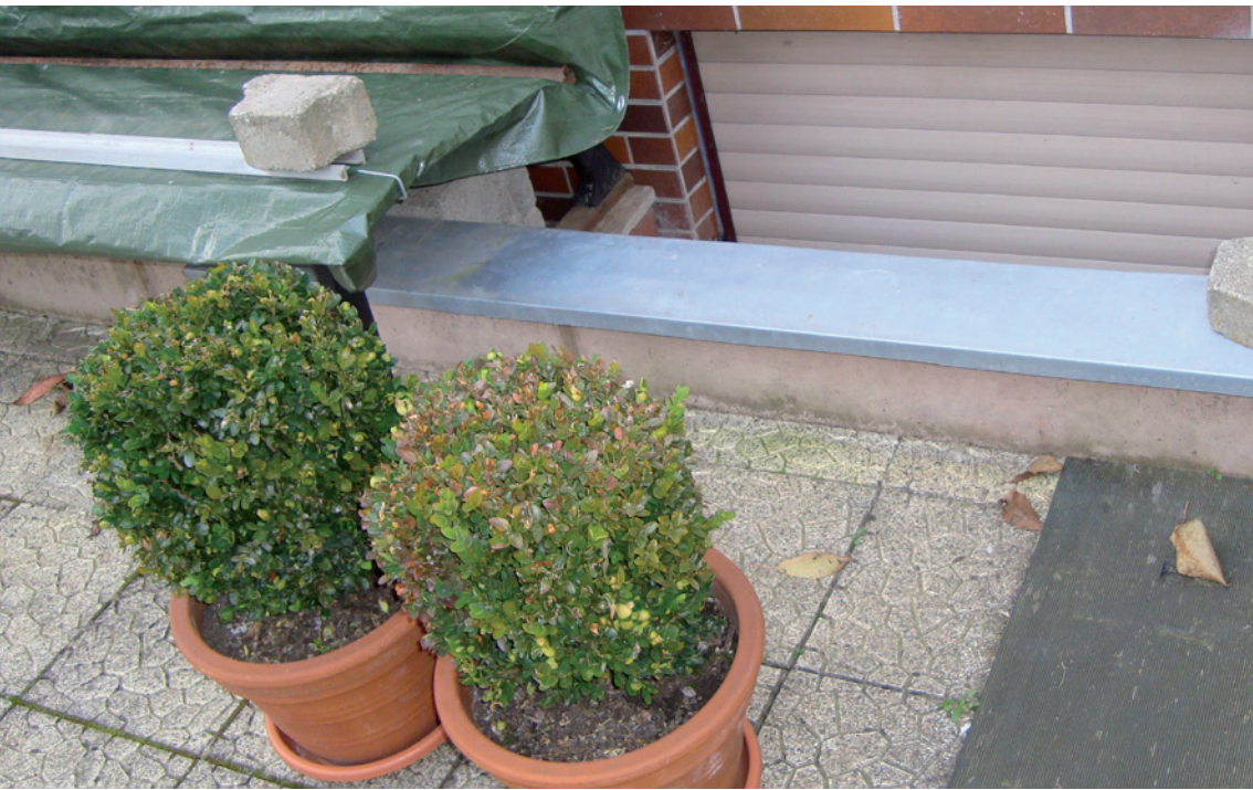
Abb. 36: Zum Schutz gegen eindringendes Wasser wurde eine Mauer vor das Kellerfenster gesetzt.
