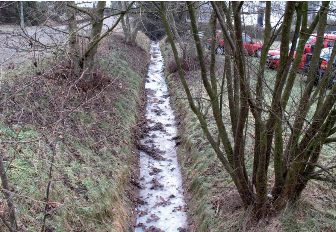
Abb. 12: Begradigte naturferne Gewässerstrecke ohne Ausuferungsmöglichkeit
