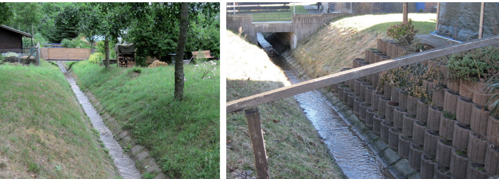
Abb. 15: Übergangshilfe und Einengung des Abflussquerschnitts
