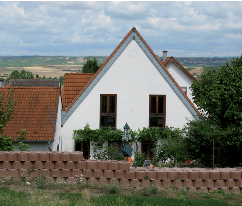
Abb. 34: Mauer aus Flora-Wall-Steinen zum Schutz vor Außengebietswasser
