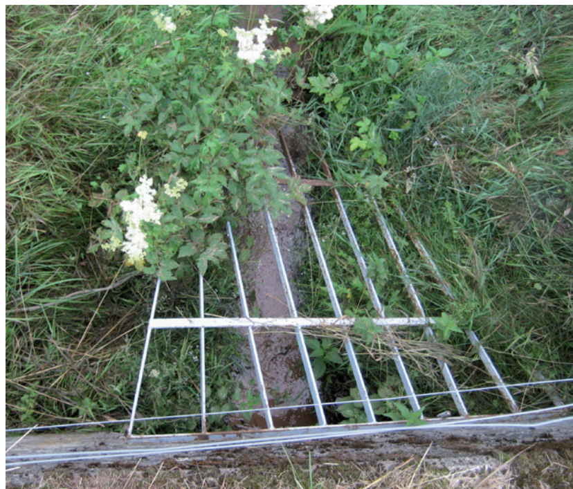
Abb. 13: Zaun im Gewässerquerschnitt (oben) und Rechen im Einlauf einer Verrohrung (unten)
