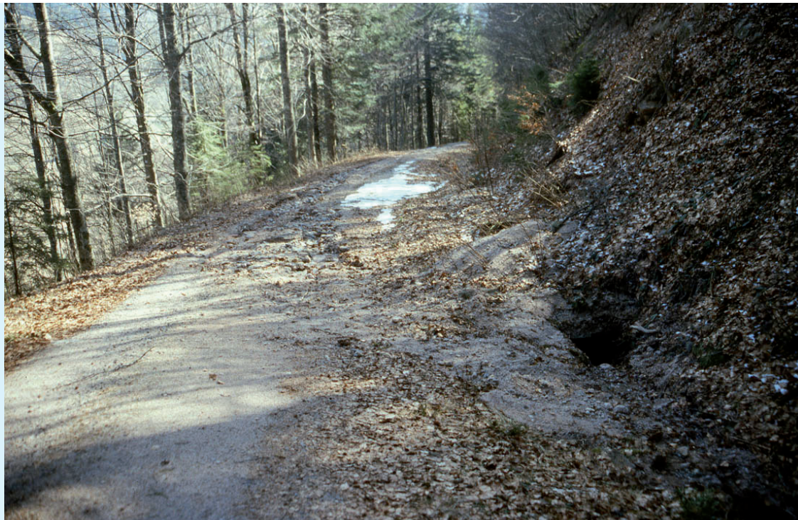
Abb. 30: Auffüllung der bergseitigen Böschung vor dem Doleneinlauf
